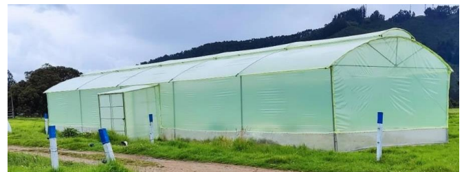
Figura 2. Invernadero construido en las instalaciones de la Universidad de La Salle en el municipio de sopó, Cundinamarca.
